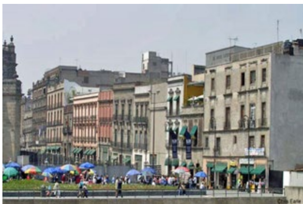
اثرات فرونشست بر نشست غیر یکنواخت ساختمان‌ها در مکرکوسیتی
